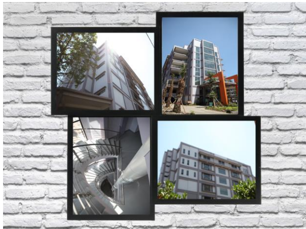
Gambar: Perkembangan Pembangunan Gedung C
